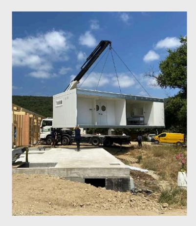
• Ossature acier galvanisé / Plancher bois-ciment / Revêtement de sol carrelage R12 / Panneaux sandwich acier laqué 80mm mousse PU.
