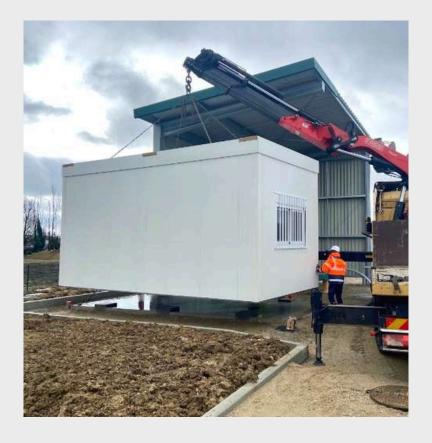
Ossature acier galvanisé / Plancher bois-ciment / Revêtement de sol carrelage R12 / Panneaux sandwich acier laqué 80mm mousse PU.
